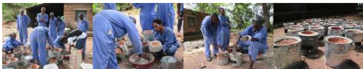
Pose du liant sur insert
